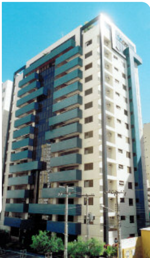
RESIDENCIAL HUGO HAMILTON: UMA DAS OBRAS DA EBEG EM GOIÂNIA
