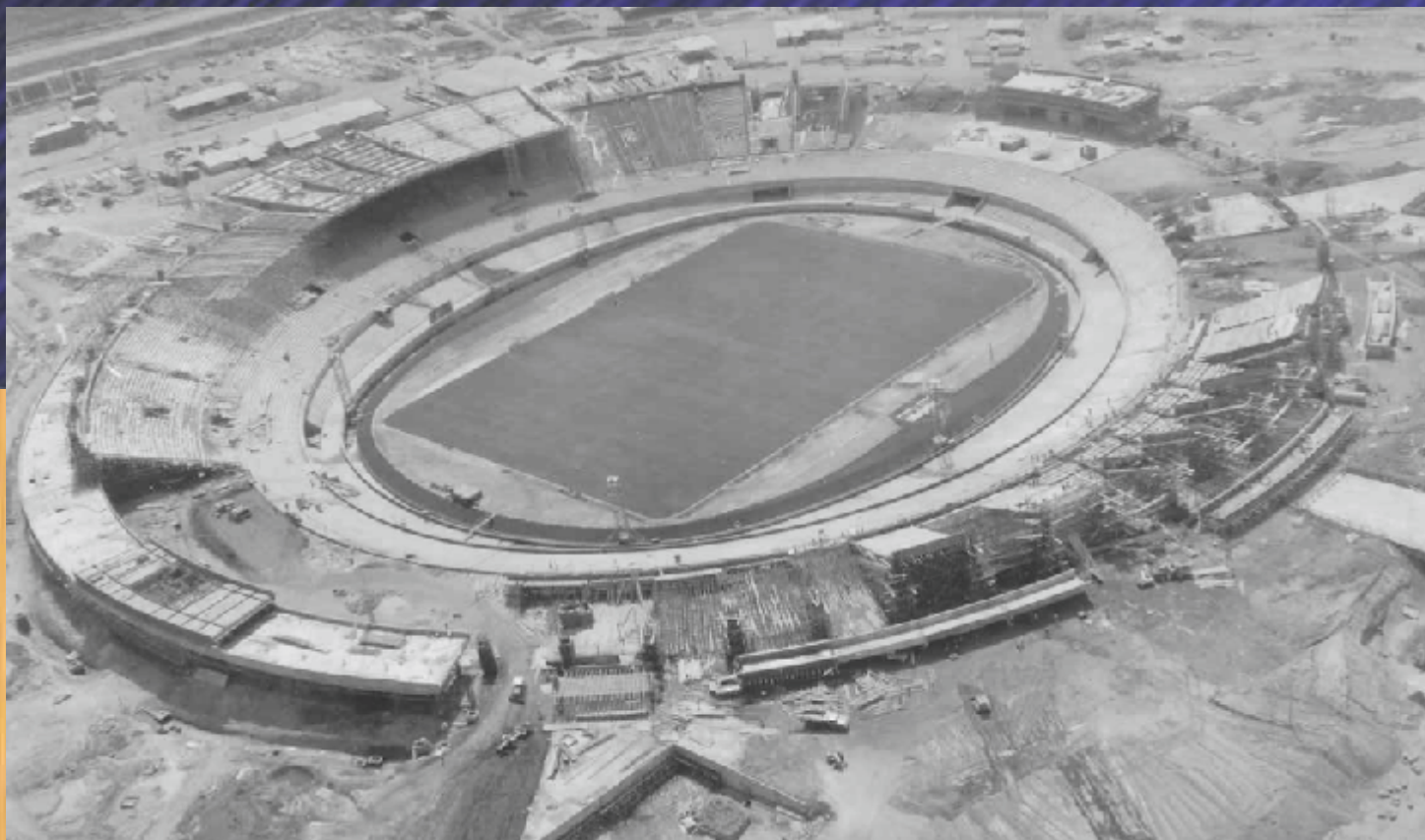
Estádio em construção
