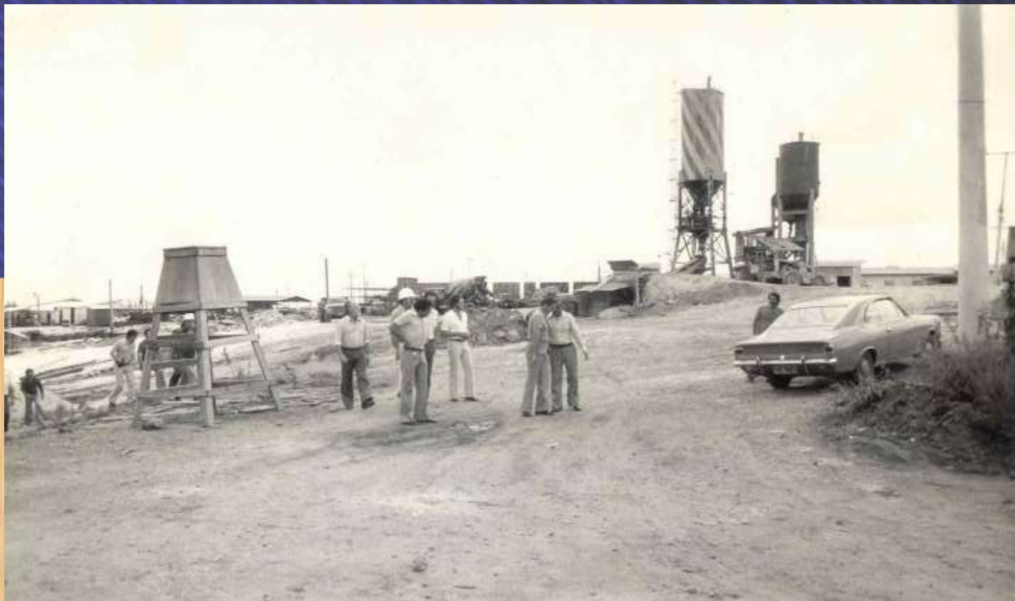
Central de concreto - Início das Obras
