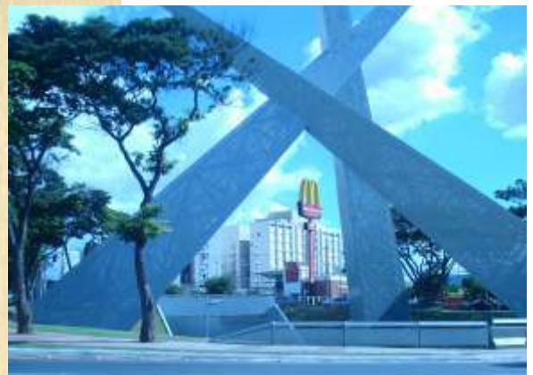
Viaduto Latif Sebbá
