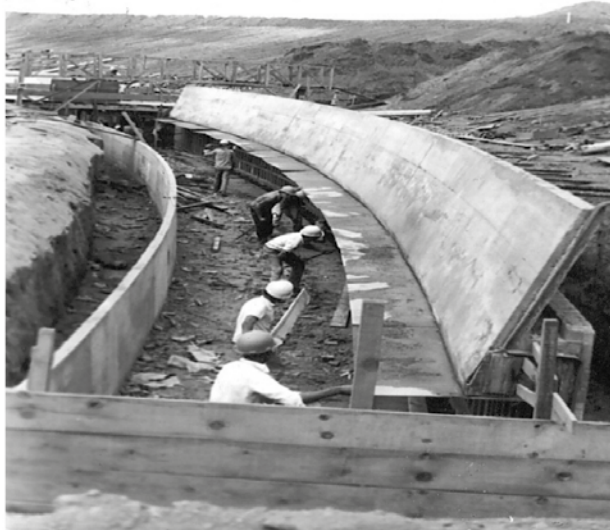
Estádio Serra Dourada em construção, 1973 ACERVO IÚRI RINCON GODINHO
