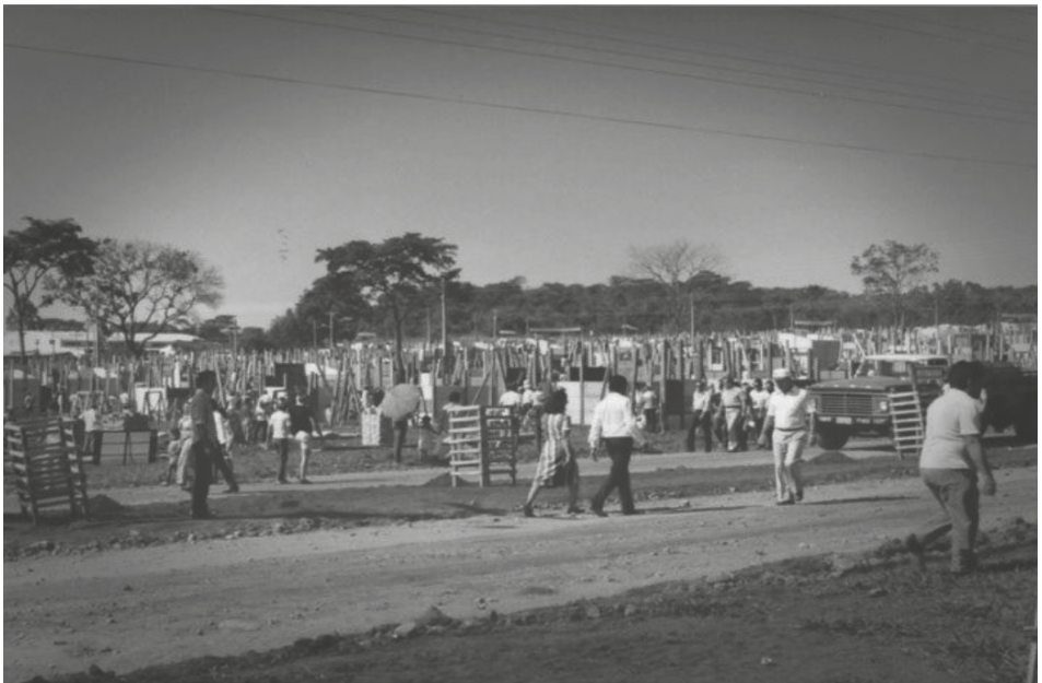
Construção da Vila Mutirão, com mil casas em um dia PROGRAMA GOLÁS DE NORTE A SUL
